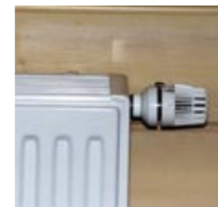
Radiator met thermostatische kraan.
