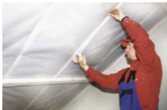
Luchtdicht maken door het tapan van het damp scherm.
