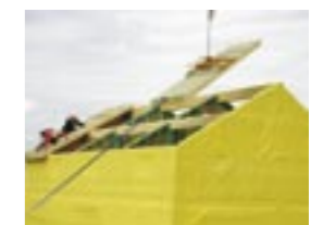
Isolatie van hellend dak met isolerende dakelementen.
