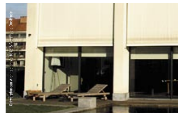
Oververhitting vermijden door gebruik van zonnewering.
