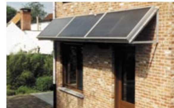
Zonnepanelen voor de productie van warm water.
