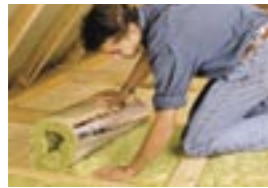
Isolatie van de zoldervloer met minerale wol.
