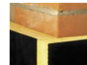
Isolatie van spouwmuur met minerale wol: zorgvuldige aansluiting op de hoeken.
