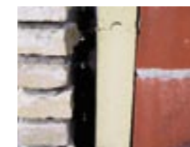
Isolatie van spouwmuur met PUR.
