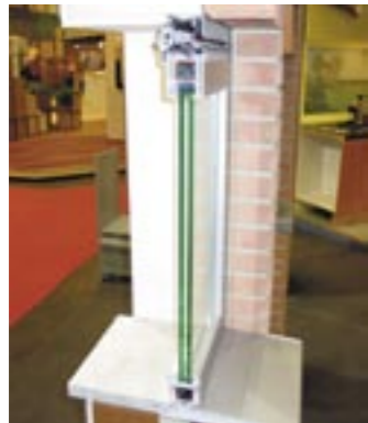
Doorsnede van venster met hoogrendementsbeglazing en ventilatierooster.
