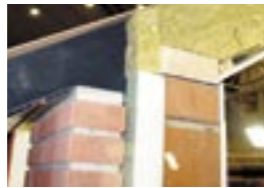
Vermijden van koudebrug via continu doorlopende isolatielijijn.
