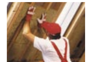
Isolatie van hellend dak met minerale wol.
