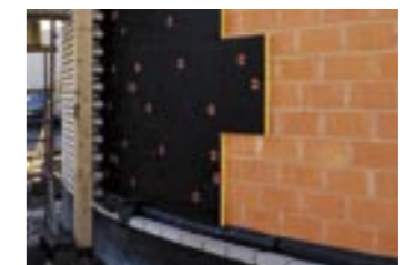
Metselen van binnenmuur. Daarna isolatie aanbrengen. Tot slot gevelsteen optrekken.
